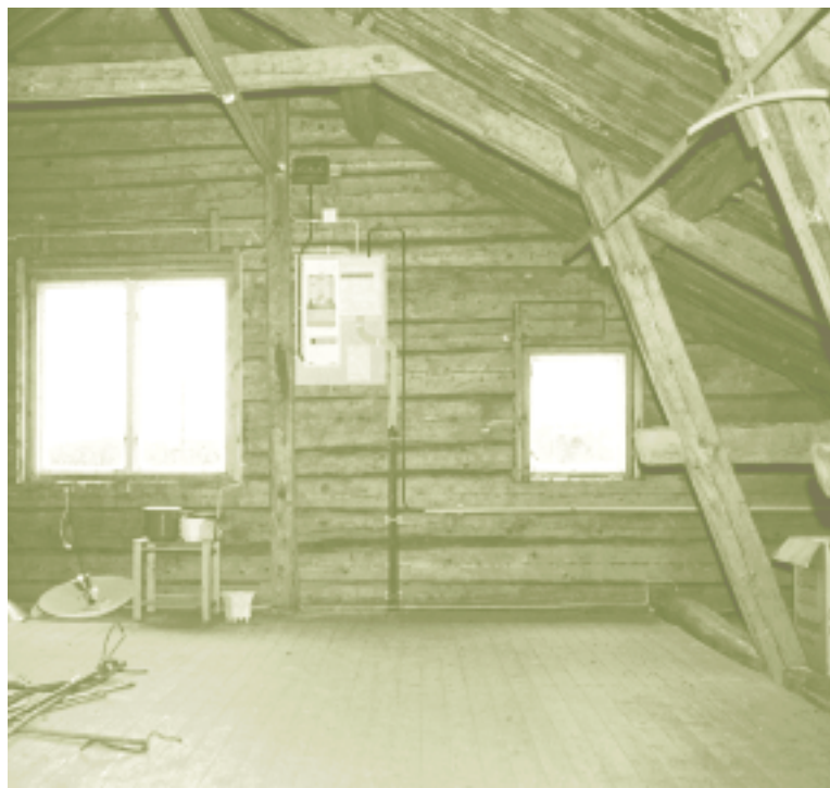
Vinden skall byggas om till boenderum.
